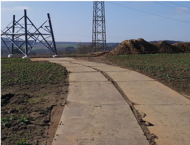
Abbildung 6: Temporäre Zuwegung über Fahrbohlen
