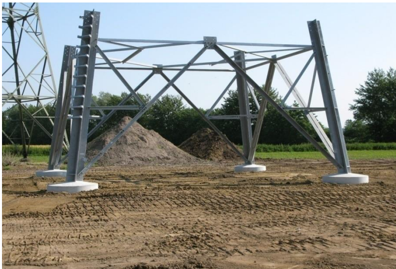
Abbildung 10: Montierter Mastfuß
