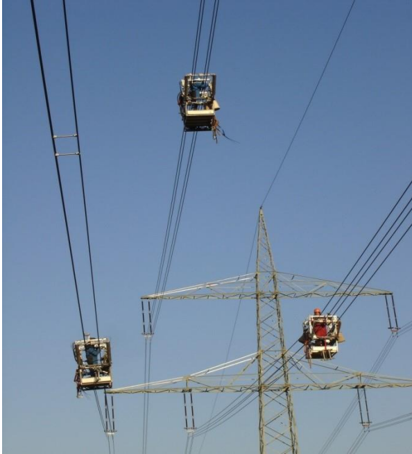
Abbildung 15: Montage der Feldbündelabstandhalter mit Fahrwagen
