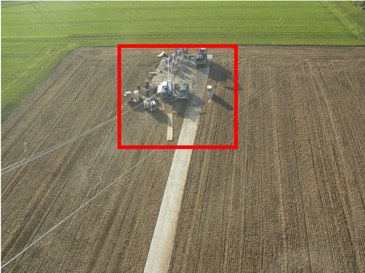
Abbildung 14: Windenplatz eines 4er-Bündel-Seilzuges (rot: Baustelleneinrichtungsfläche, unmaßstäblich)
