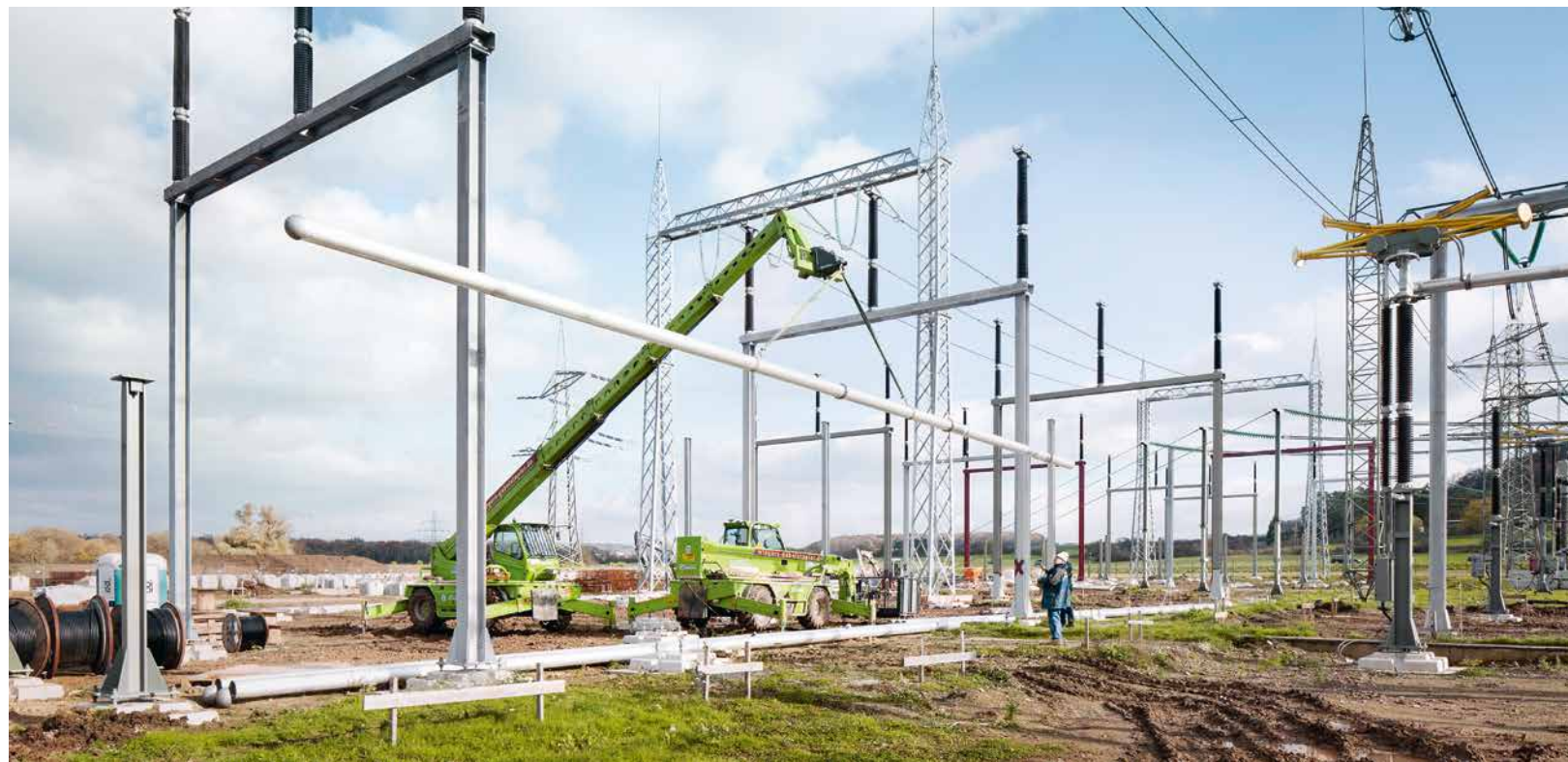
Die Baustraßen werden während der Bauzeit für die Tiefbauarbeiten und die Montage der Anlagenkomponenten genutzt
